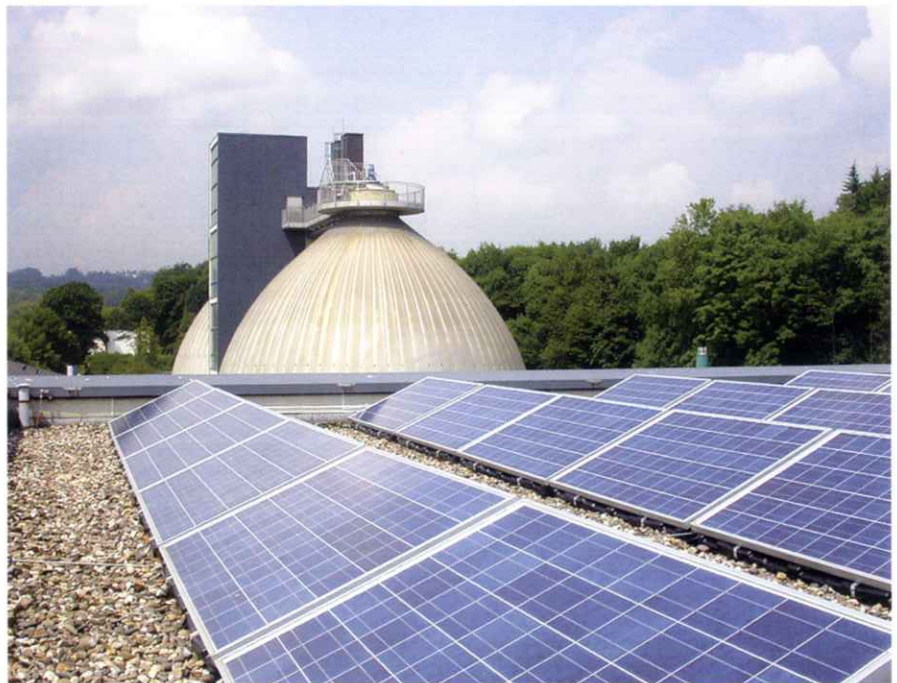
Kläranlage Kohlfurt des Wupperverbandes
